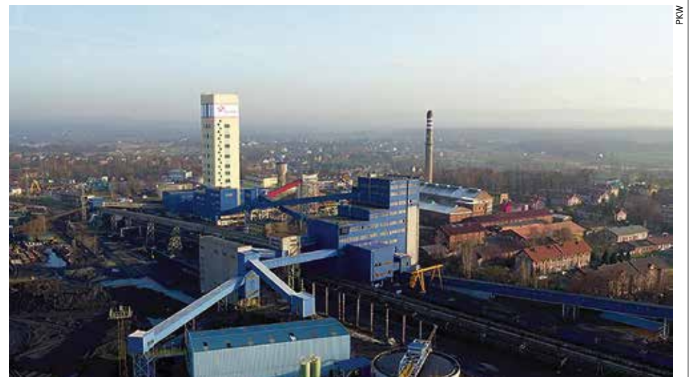
Dwa silniki kogeneracyjne spalające metan pokrywają około 40 proc. zapotrzebowania na energię elektryczną kopalni Brzeszcze
